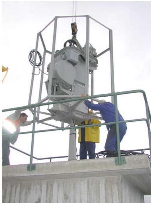
Das Aufsetzen des Kranes auf die „Königsachse“, bei den Krantechnikern „Hochzeit“ genannt, erfordert Fingerspitzengefühl.
