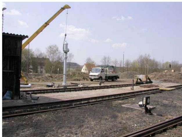
Das Standrohr ist errichtet und wird mit der Stahlbasisplatte verschraubt. Die Verbindung zu den Aggregaten des Schachtes, Steigrohr, Schieberventil, Windkessel, Vorschieber, ist hergestellt.
