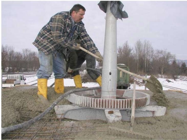
Die Witterung erlaubt es, die Plattform des Kransockels mit definitiver Betonierung der Königsachse mit Zahndrehkranz fertig zu stellen.
