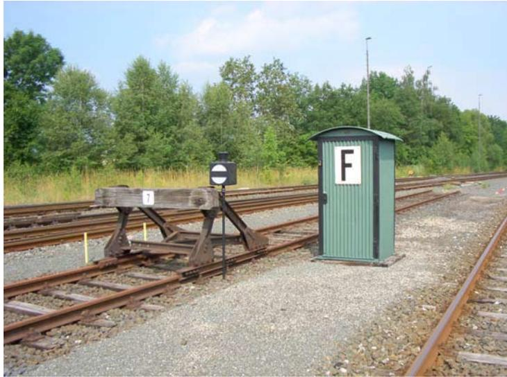
Die Fernsprechbude bei Gleis 7 aus Kirchenlaibach wurde in kleinen Arbeitsschritten aufgearbeitet und im Sommer 2003 über die gelbe, reaktivierte Fernsprechsäule „gestülpt“. Somit ist die Sprechverbindung zum Fahrdienstleiter wieder hergestellt.
