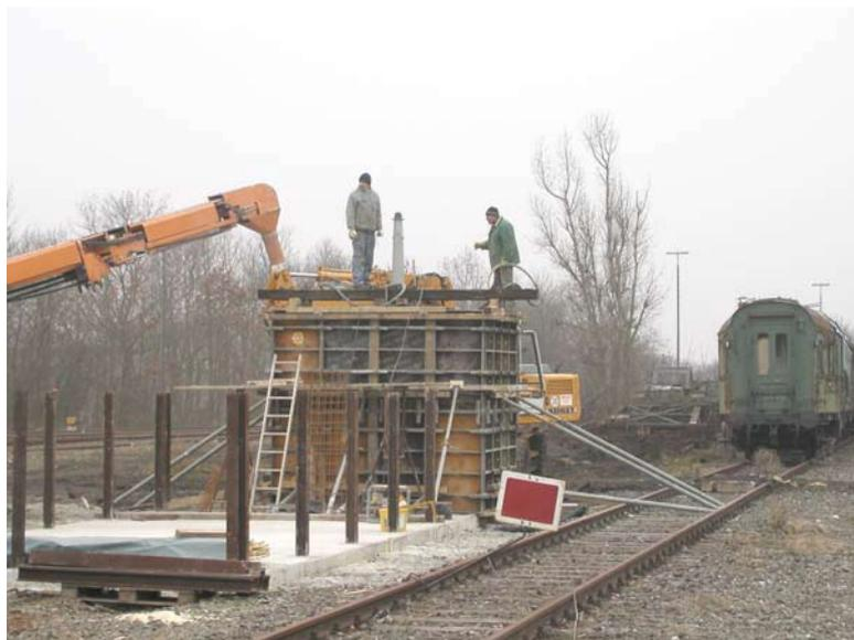
Noch vor der Frostperiode wurde der Betonssockel des Bekohlungskranes eingehaut und betoniert.
