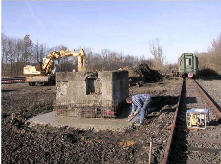
Nachdem die Finanzierung des Projektes „Die Rekonstruktion des BW des DDM“ gesichert war, begann die Kernbaumaßnahme mit weiteren Erd- und Freilegungsarbeiten sowie die Stabilisierung des Betonssockels mit schwerem Gerät.
