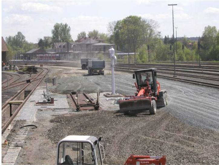
Die Pflasterarbeiten sind weitgehend abgeschlossen. Der Verbindungsweg entlang der Schlackengrube zum Bekohlungskran wurde mit Granit-Schwellensteinen aus der Zeit um 1850/60 gestaltet.
