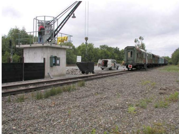
Der Kranausleger ist bereits montiert, das Lastseil eingefädelt.
