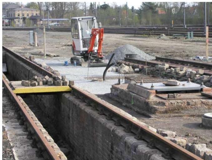
Der Wasserkransockel ist teilweise gefestigt, die stählerne Basisplatte ist montiert, die Führungsrohre zur Aufnahme der Holzmastleuchten mit den Elektroleitungen sind ins Erdreich eingebracht, der Boden wird zur Pflasterung vorbereitet.
