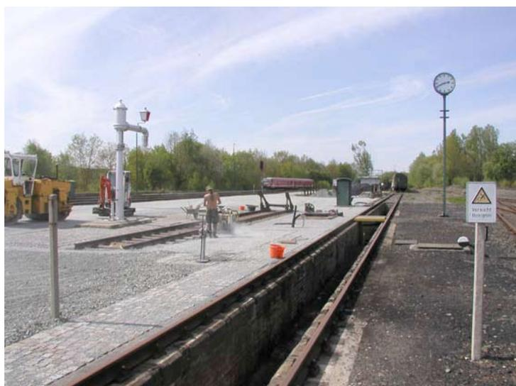
Die aufgetragene Mineralgesteinschüttung wird verdichtet, die gepflasterten Flächen werden gefestigt und plangerüttelt.
