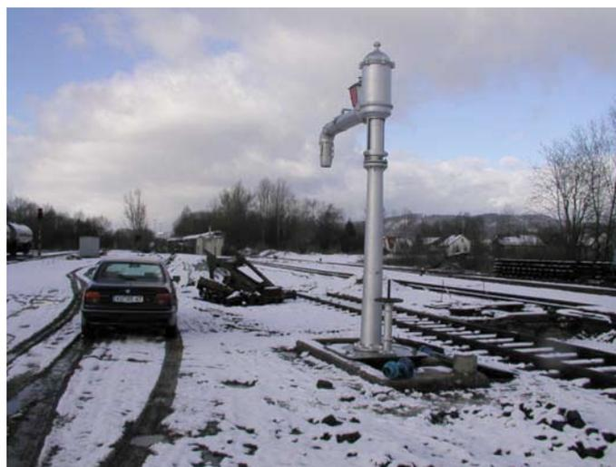
Der Winter ist eingezogen. Die Erd- und Schachtarbeiten zur Verlegung der Wasserrohre und der Elektrokabel sind weitgehend abgeschlossen, die Leitungsgräben wieder verfüllt. Die Schalung der Einhausung des Kransockels ist bereits abgenommen.
